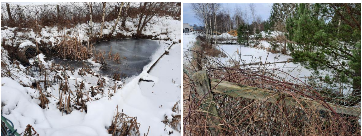
Figur 10: Fördröjningsdamm med läns för oljeavskiljning, instänglsad och försedd med skuggande plantering.
