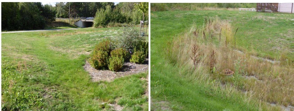
Figur 9: Svackdike med litet infiltrationsområde och kupolbrunn vid nedströmsände
